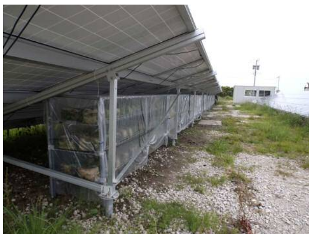
営農型ソーラーシェアリングの状況
